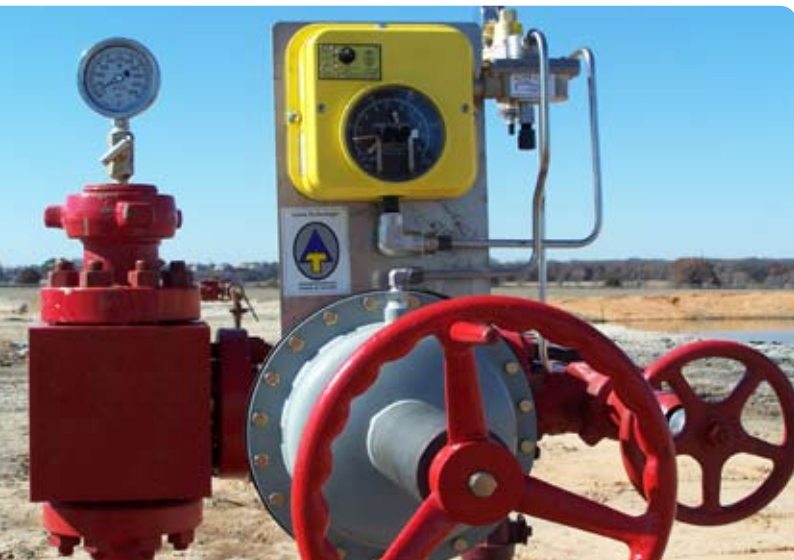
Задвижка с приводом, и электронной пилотной системой
